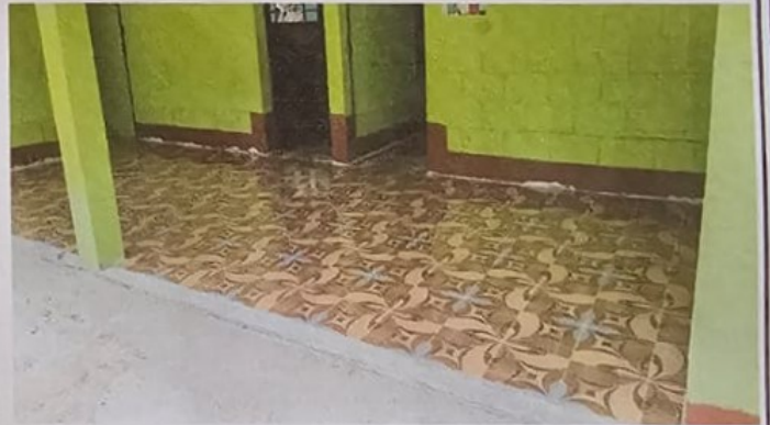
Foto 4: Mejoramiento de Piso
