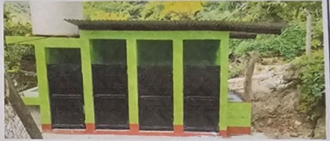
Foto 2: Mejoramiento de servicio sanitario
